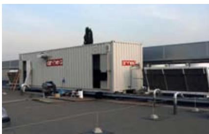
Il container sul tetto del punto vendita
