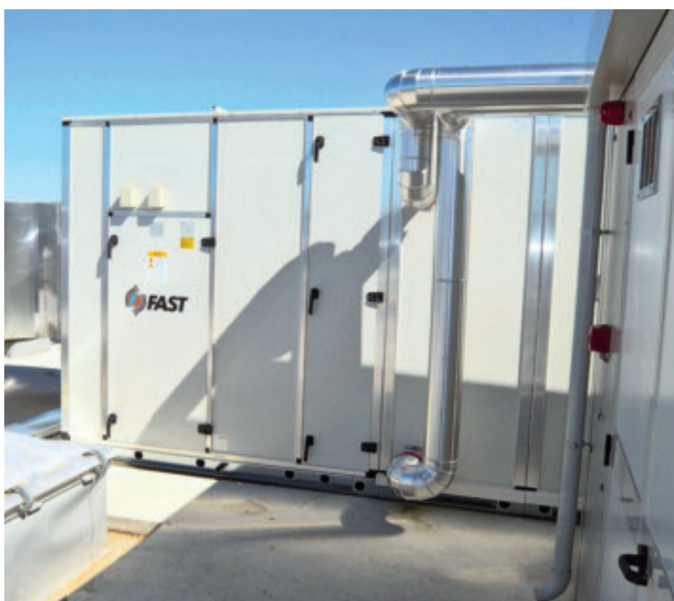
Figura 3 – Circuito acqua calda (collegato agli scambiatori Arneg) a servizio della batteria di riscaldamento interno al roof-top. Il circuito dei condensatori è in grado di produrre acqua calda fino alle temperature di mandata e di ritorno rispettivamente pari a 42°C e a 37°C. Tale circuito viene utilizzato per il riscaldamento della batteria del roof-top dell'area vendita e per il riscaldamento delle batterie degli aerotermi del magazzino
